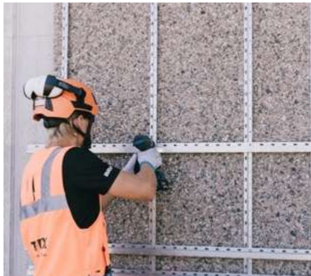
Kuva 24: Asennuskiskojen asennus
