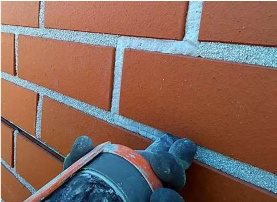
Kuva 41: Verhouksen saumaus työmaalla
