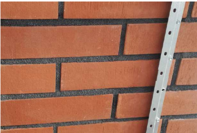
Kuva 37: Tukikisko vaihdettavalle tiililaatalle
