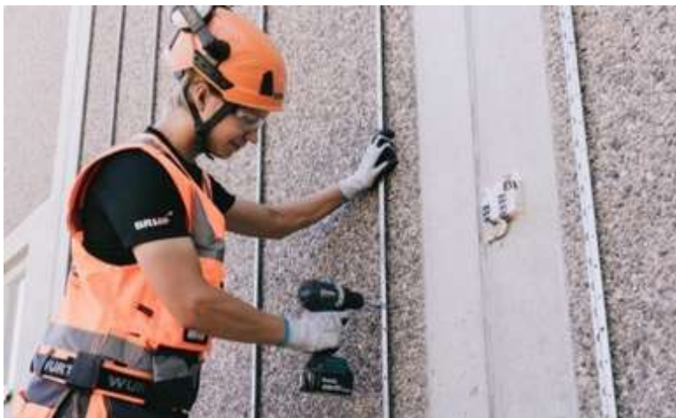
Kuva 18: Z-pystykiskot k600 jaolla, kiinnityspisteet alustaan max k400
