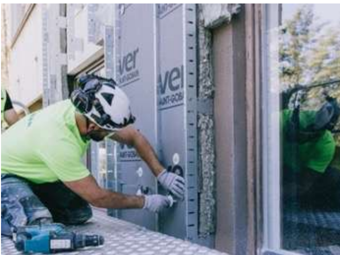
Kuva 32: Tuulensuojaeristyksen asentaminen
