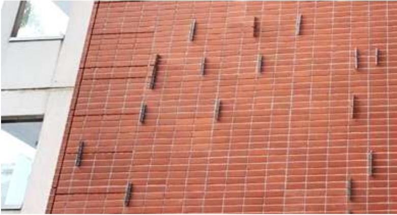
Kuva 34: Tiilipinnan tasaisuus varmistettu ennen saumausta
