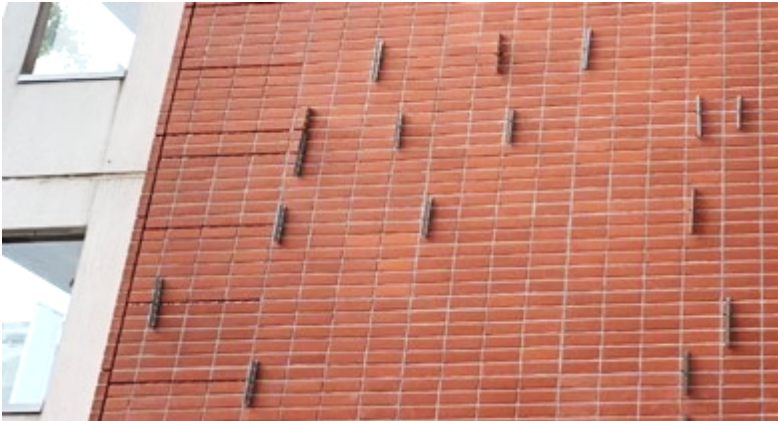
Kuva 34: Tiilipinnan tasaisuus varmistettu ennen saumausta
