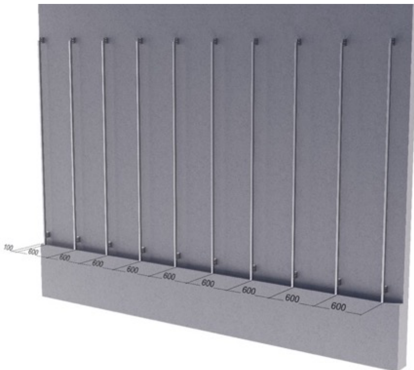
Kuva 30: Eristyskiskojen oikaisu niin että ala- ja yläkiinnikkeet ovat paikoillaan
