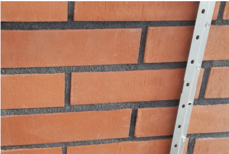
Kuva 37: Tukikisko vaihdettavalle tiililaatalle
