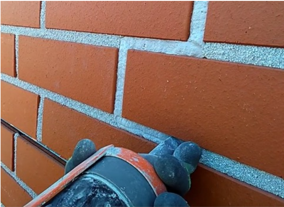
Kuva 41: Verhouksen saumaus työmaalla
