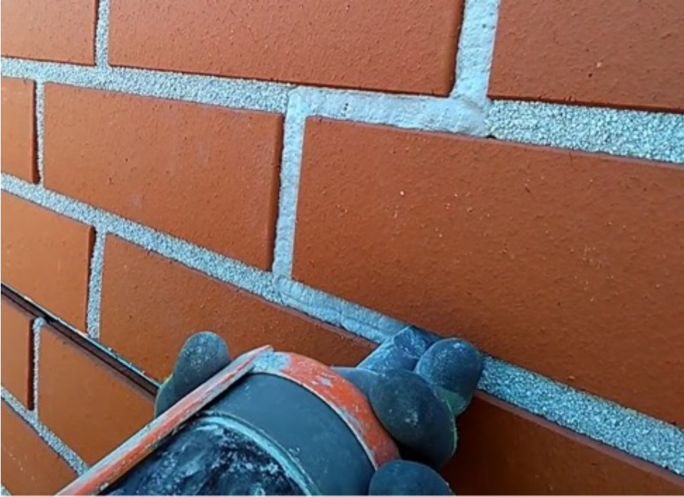
Kuva 41: Verhouksen saumaus työmaalla
