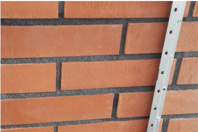
Kuva 37: Tukikisko vaihdettavalle tiililaatalle
