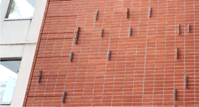
Kuva 34: Tiilipinnan tasaisuus varmistettu ennen saumausta
