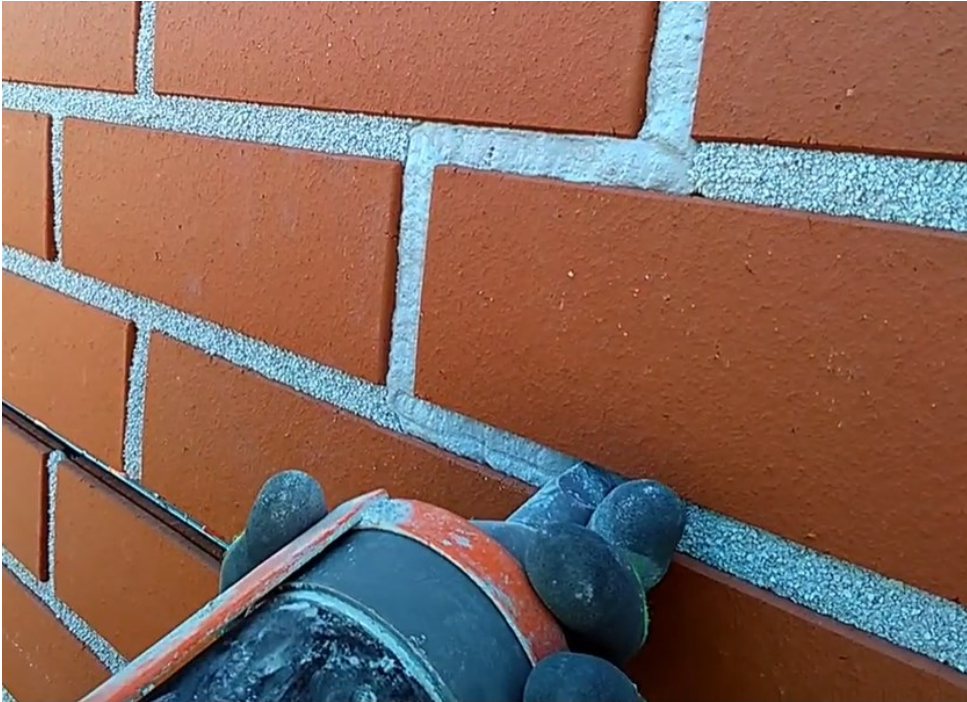
Kuva 41: Verhouksen saumaus työmaalla
