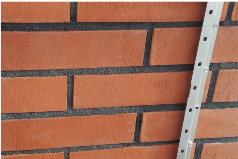
Kuva 37: Tukikisko vaihdettavalle tiililaatalle
