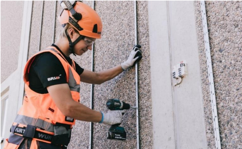
Kuva 13: Z-pystykiskot k600 jaolla, kiinnityspisteet alustaan max k400
