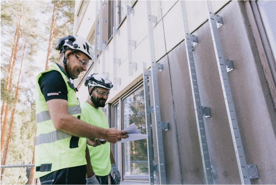
Kuva 22: Eristyskiskojen asennus k600 jaolle
