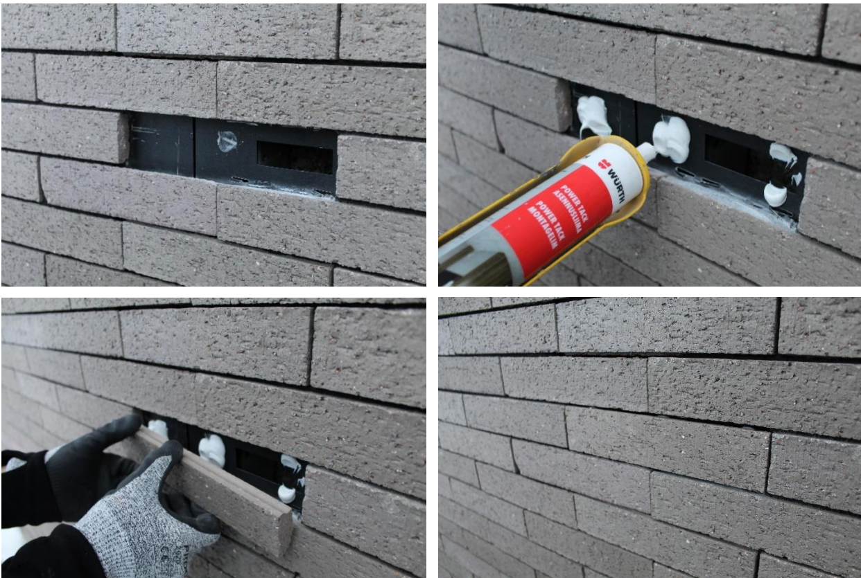
Kuva 29: Laatan liimaamisen vaiheet, huomioitava riittävä liiman määrä
