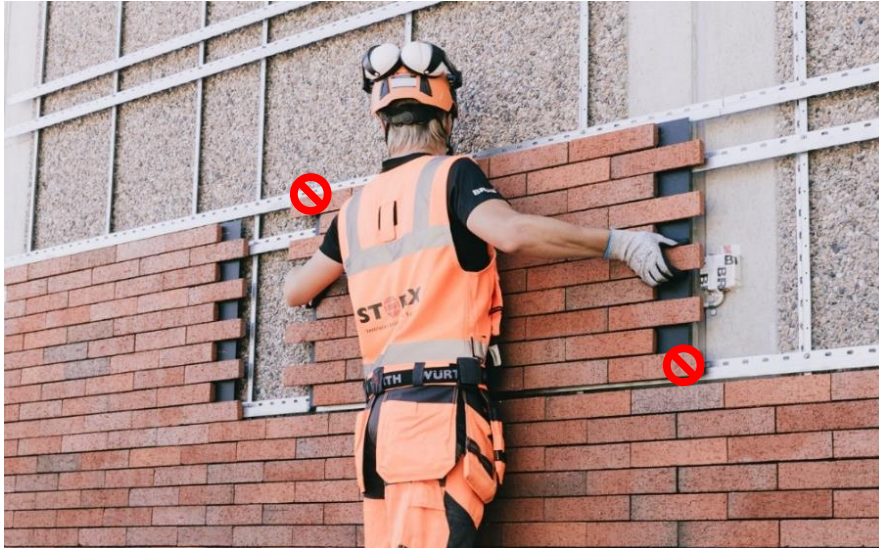
Kuva 25: BRIX-verhouslevyä nostetaan levyn keskeltä
